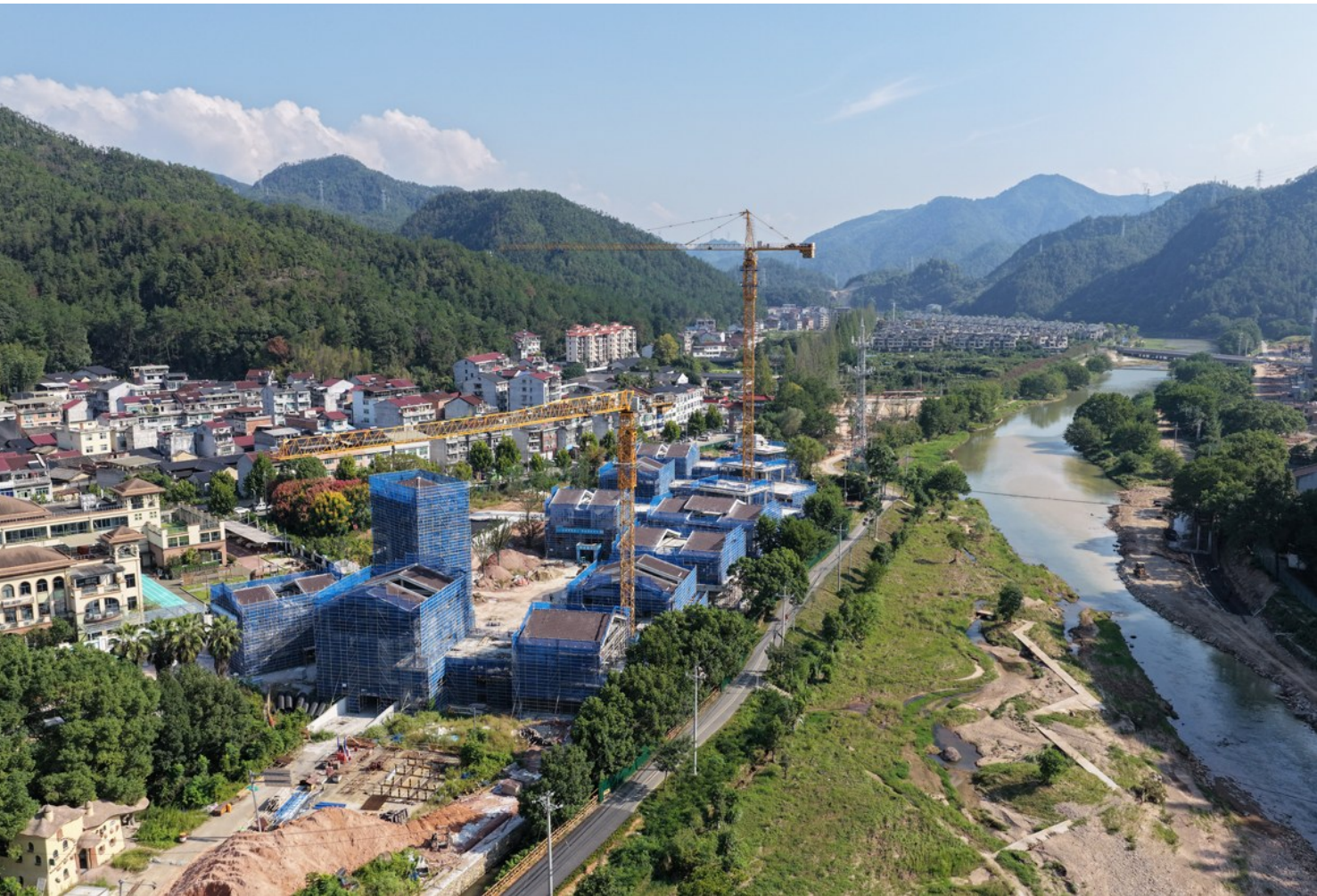
眼下,县城东公共停车场(人防停车场)工程建设如火如荼,各项施工工作稳步开展。
