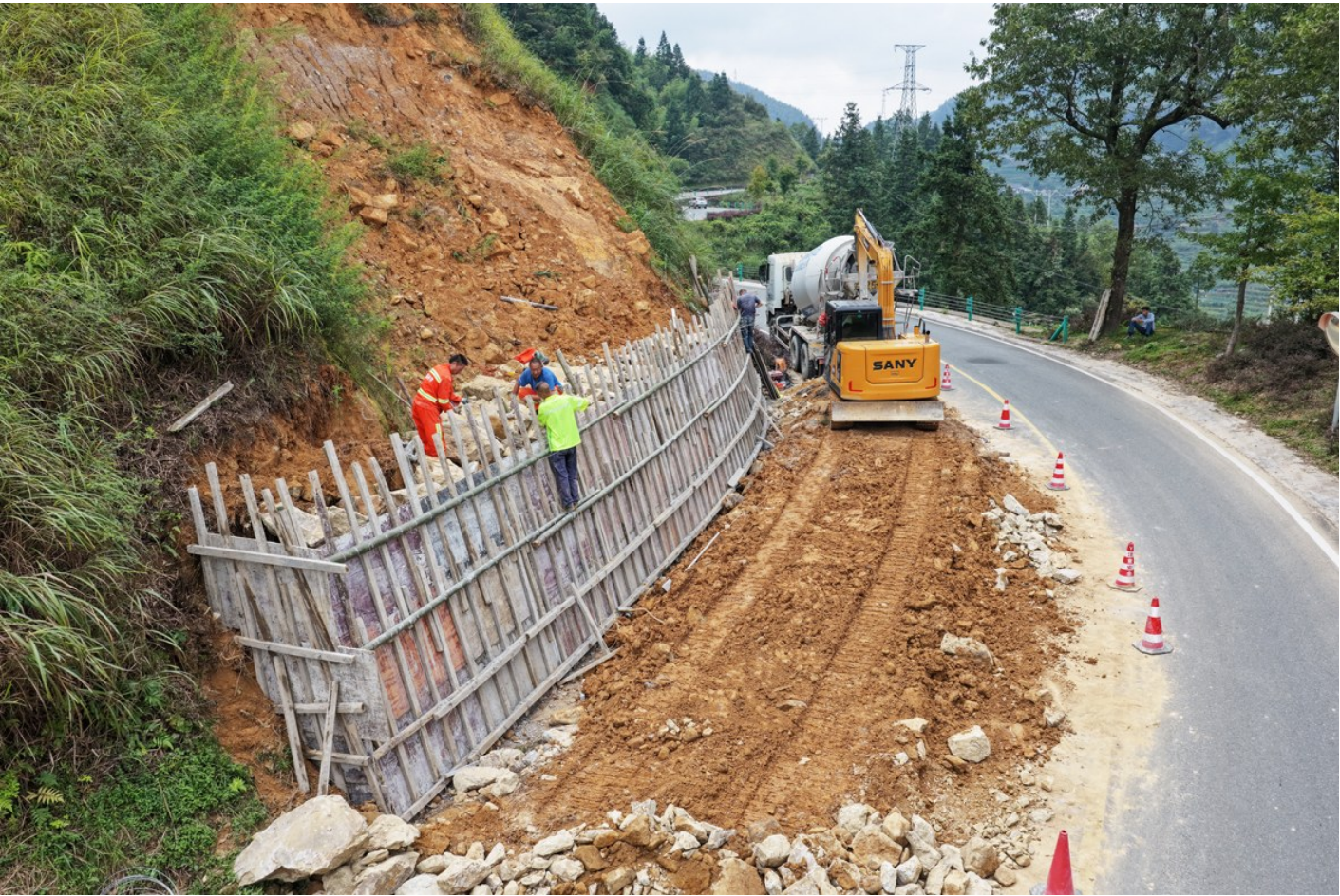
近日，我县组织人员在仙景线K244+000附近塌方路段开展道路抢修，确保车辆畅通无阻和村民出行安全。
