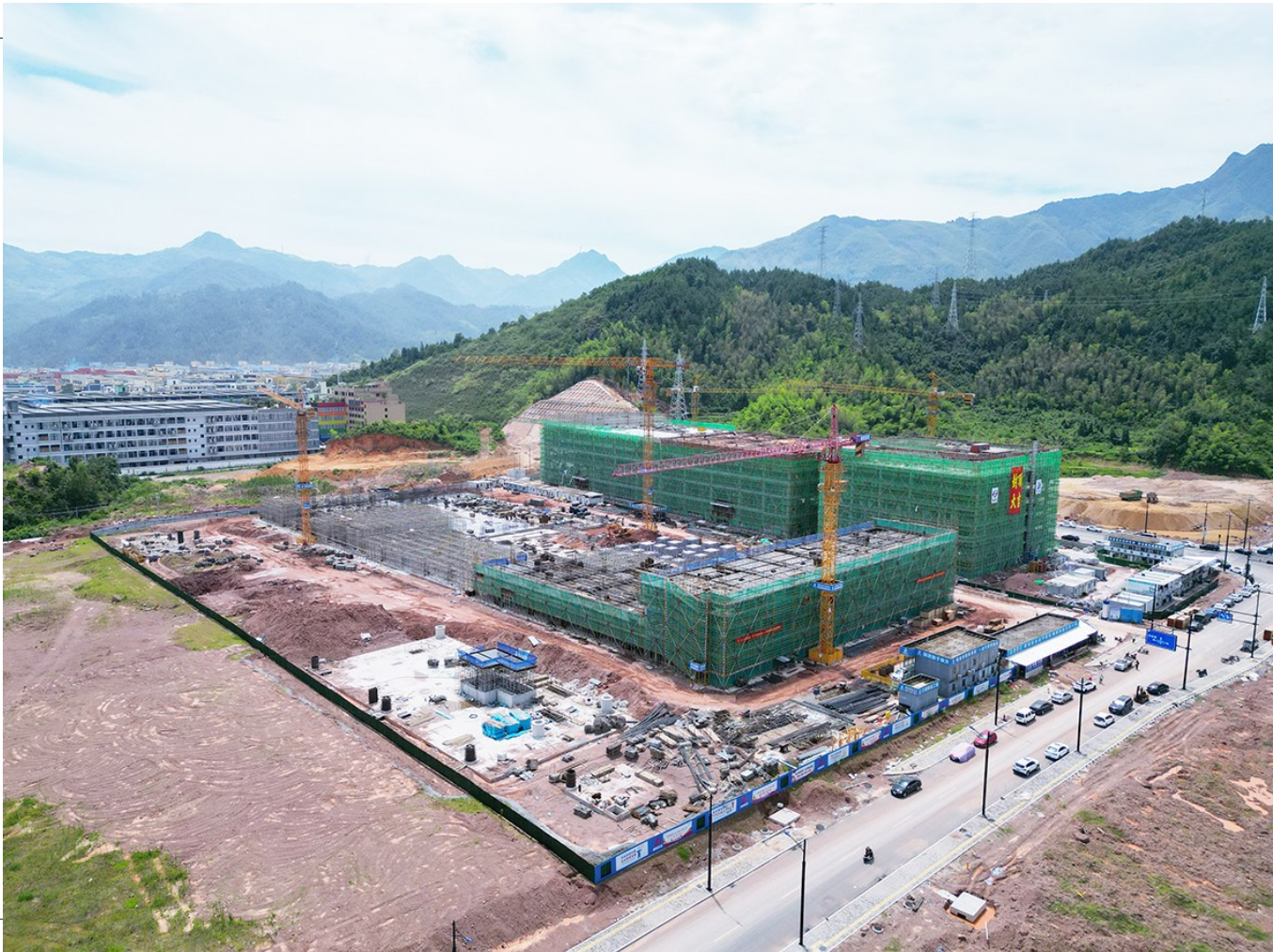
连日来,云和经济开发区赤龙区块内,浙江晶元电子材料有限公司电子级硅材料及抛光片项目施工现场机械轰鸣,工人们全力以赴抢抓建设进度,力争早日建成投产。
