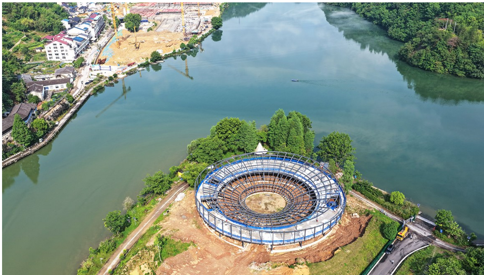
近日,云谷-云和三江口建筑景观项目现场一派繁忙景象,工人们正加紧施工。目前主体结构施工基本完工,后续将进行室内装饰装修工程。
