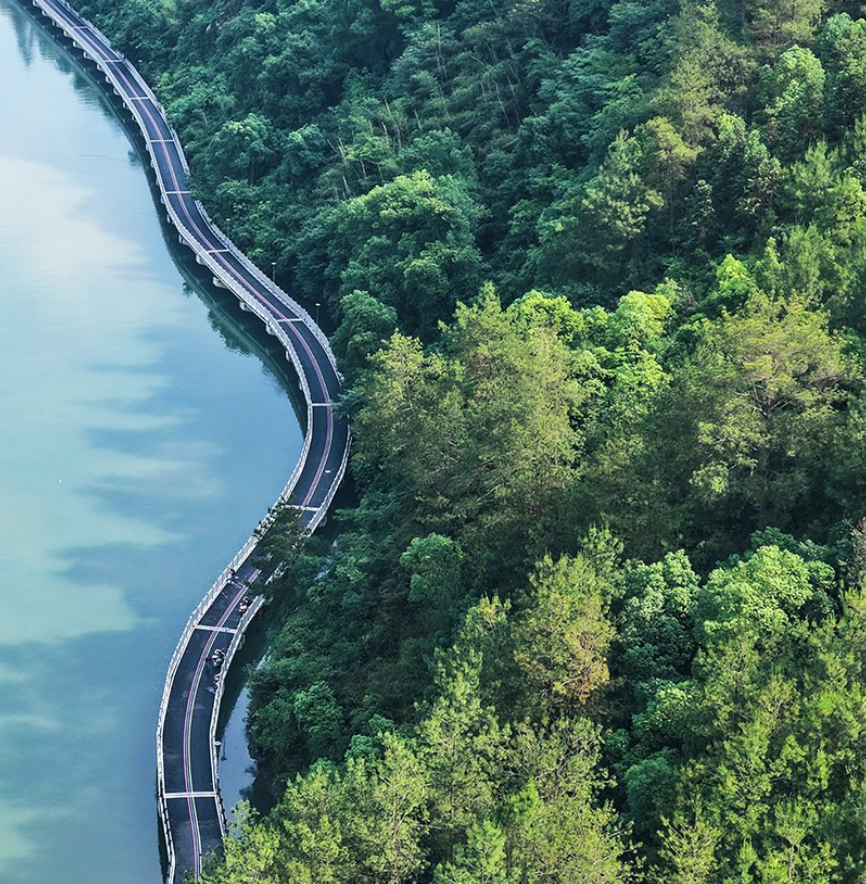
龙泉溪云和段综合治理工程以岸坡整治及管理道路建设为主,统筹兼顾惠民利民设施,助力沿线乡村振兴。目前该工程已取得阶段性成果,预计今年年底基本贯通,2027年完工验收。
