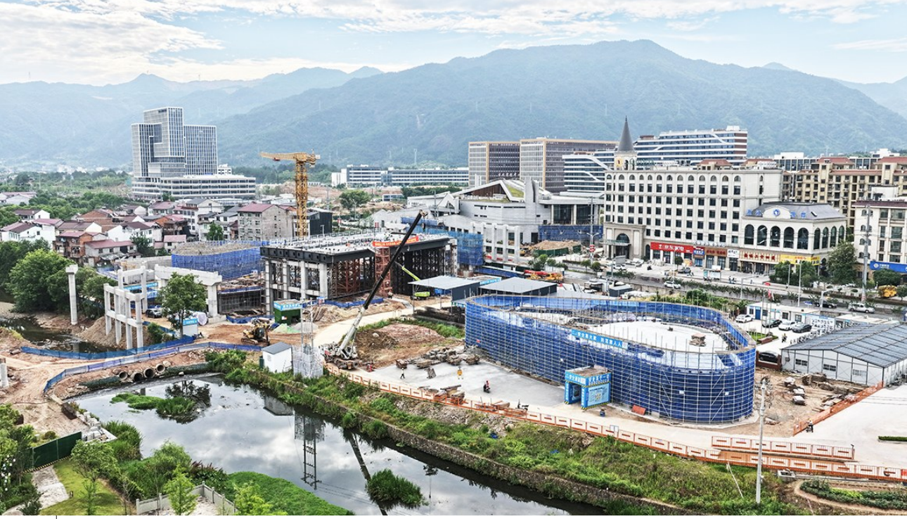
近日,木玩童话小镇配套(仙境丛林与小镇阳台)项目正加紧施工,建设现场一派繁忙,建成后我县城区将再添一处靓丽新景。
