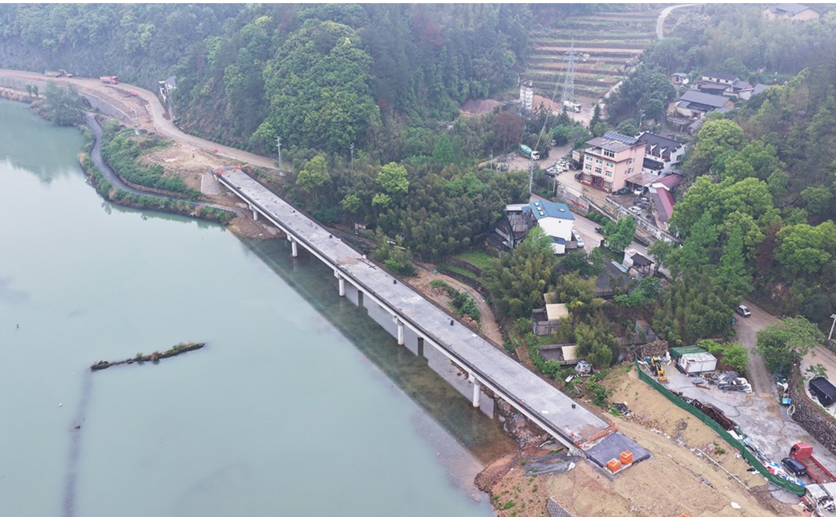
连日来,局龙线一期改建工程吾思岭脚大桥段正加紧建设中,建成后将进一步便利群众出行。
