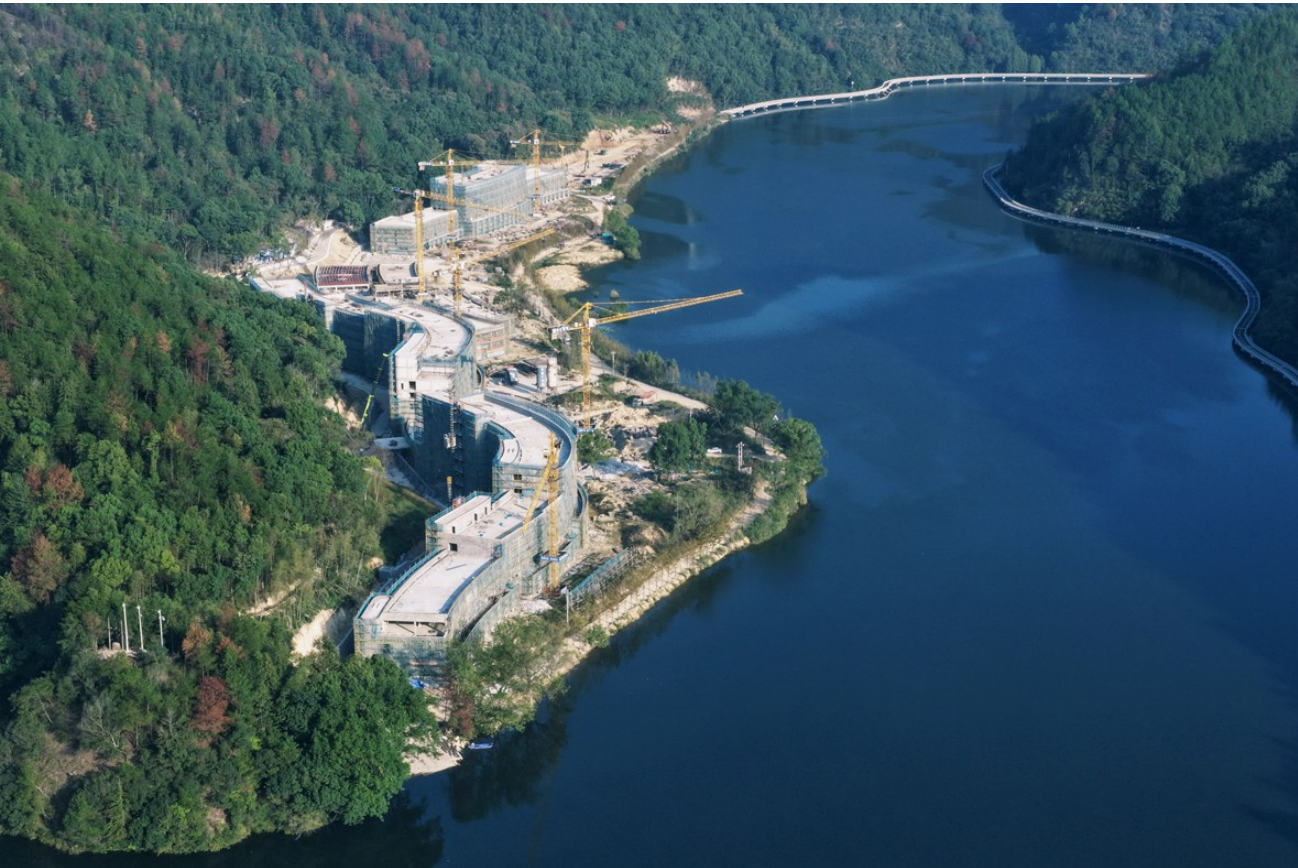
近日,那云和湖全域旅游项目一期三潭隐奢度假庄园紧张施工中,该项目预计2027年年底完工建设。
