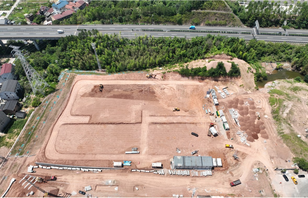
日前,杨柳河现代新型绿色产业园建设项目(C区块)正式开工建设。图为施工现场。
