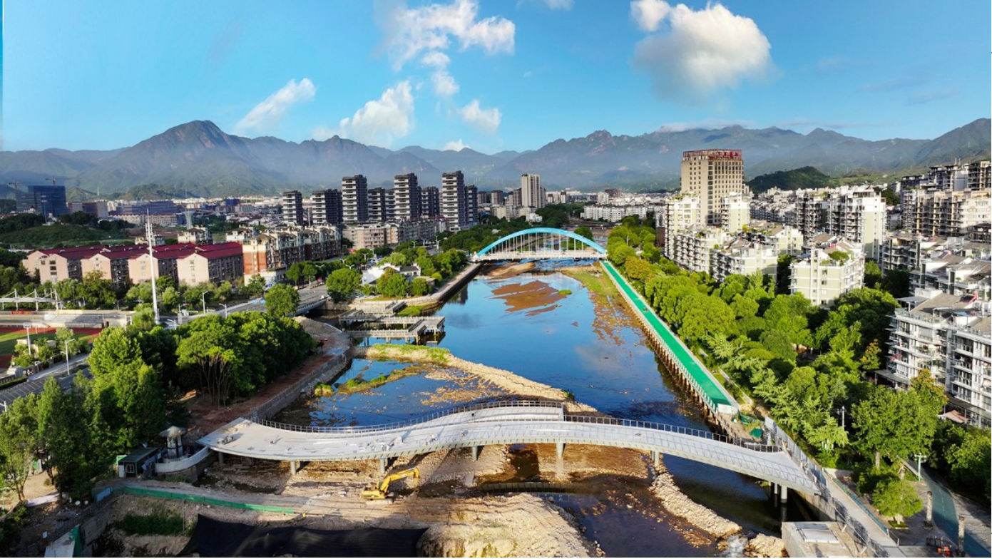
近日,工人们冒着酷暑,积极推进浮云溪流域(县城段)治理工程之一的龙吟桥工程,为县城再添打卡美景。 刘海波 文/摄
