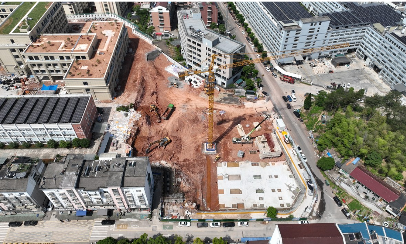
连日来,县中等职业技术学校公寓工程施工现场一派繁忙景象,项目正以扎实的节奏推进基础施工,预计2026年9月建成并投入使用。
