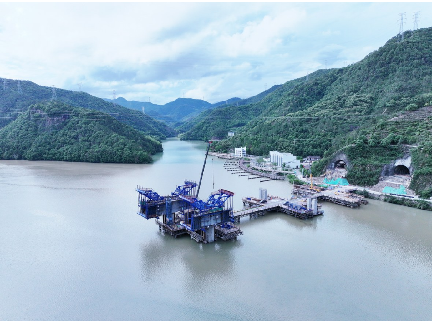
近日,235国道云和段改建工程石塘水库大桥施工现场一片繁忙,工人们正紧锣密鼓地开展主墩现浇箱梁施工。
