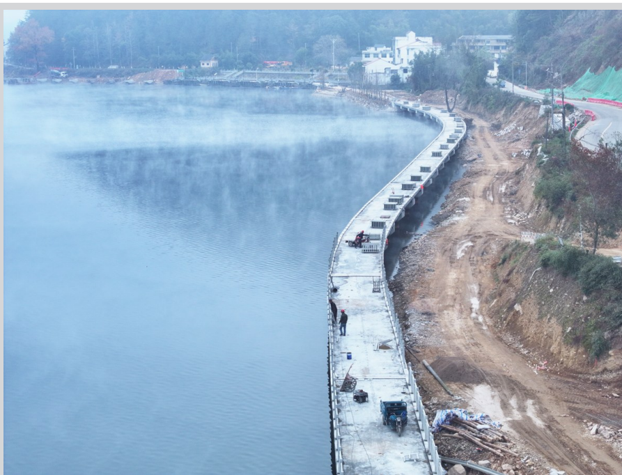
近日,龙泉溪综合治理工程-云和湖青龙潭至菖蒲壑段绿道项目工程接近尾声。图为项目现场。
