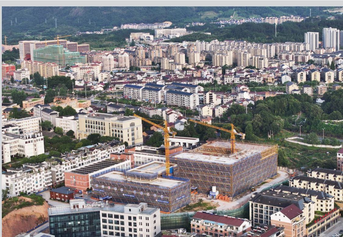
连日来,在县职技产教融合中心二期工程施工现场,工人们正全力以赴推进工程建设。
