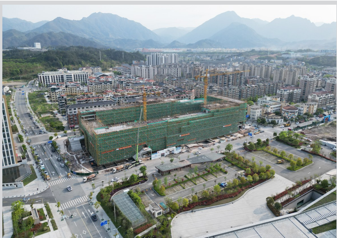
连日来,在县木玩创客空间—人才公寓项目施工现场,工人们正抢抓工期建设,项目完成后将更好地为我县发展提供人才服务保障。
