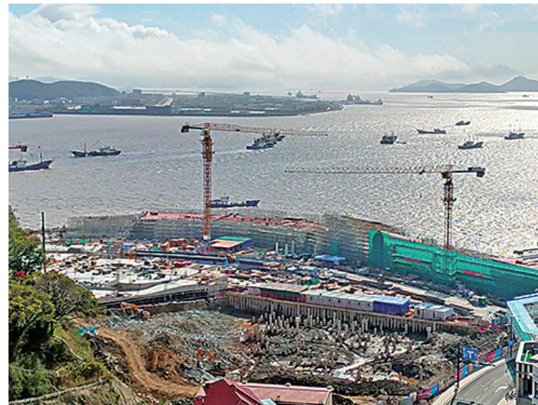
半升洞客运站施工现场
