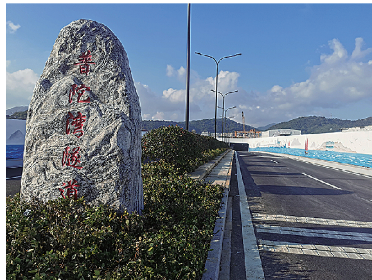
普陀湾隧道鲁家峙进出口
