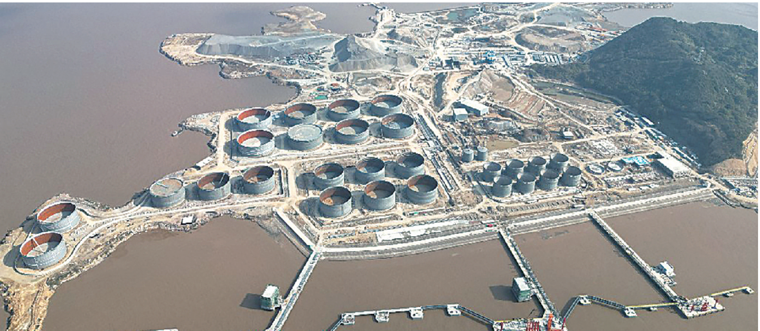
虾峙东白莲岛油品储运工程航拍。
