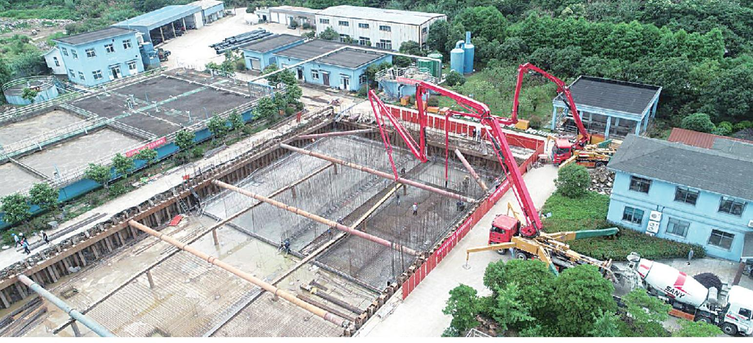
本报讯(通讯员 刘生国)6月21日,六横镇城镇污水处理厂二期项目建设工地机声隆隆、车来车往,两台长臂搅拌机车将大量的混凝土输送到建设中的污水处理生化池里。工人们忙着在生化池底部浇筑混凝土。
