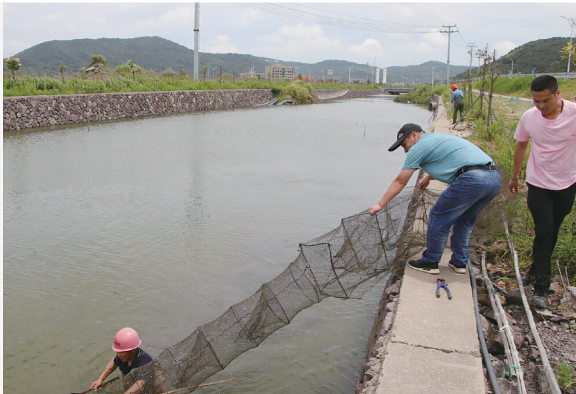
连日来,六横水利部门会同城管部门,清理辖区主要防洪排涝河道里的地笼网、扳罟等,提前做好梅雨季防洪排涝工作,防止遇到强降雨天气时,河道受阻、排水不畅,对农业生产和围塘养殖业造成经济损失。
