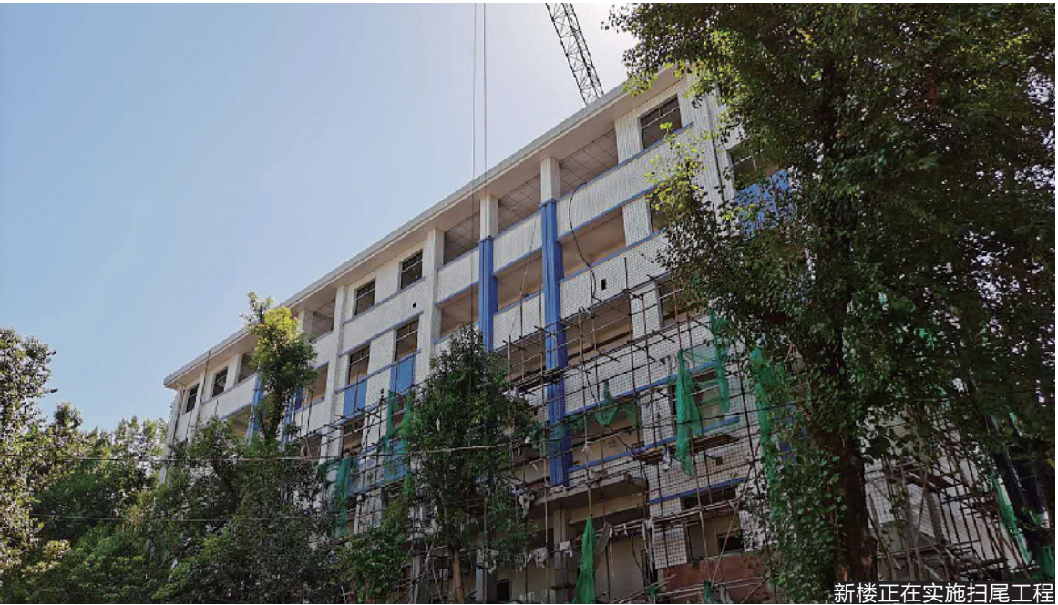
新楼正在实施扫尾工程
