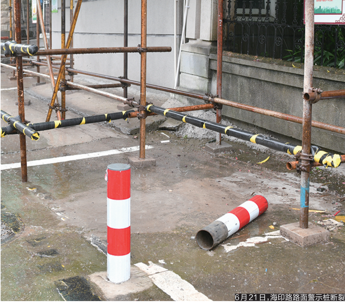
6月21日,海印路路面警示桩断裂
