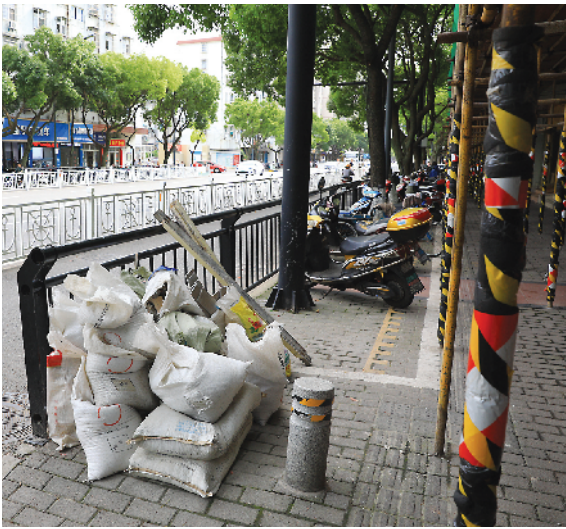
▲市场正门西侧建筑材料乱堆放
