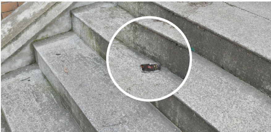
▲后门阶梯烟盒未及时清理,管道破损,部分电线裸露
