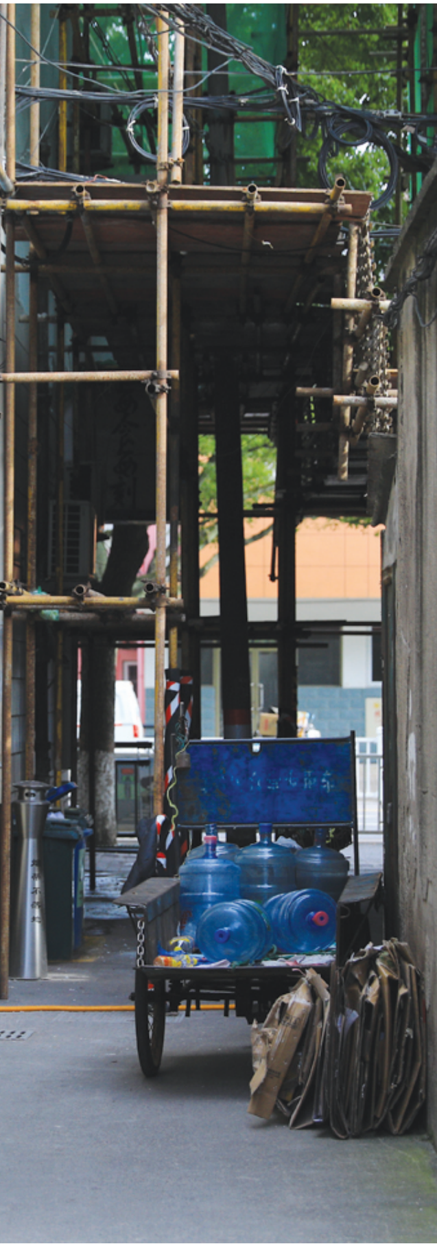
▲市场西侧背街小巷垃圾杂物乱堆放
